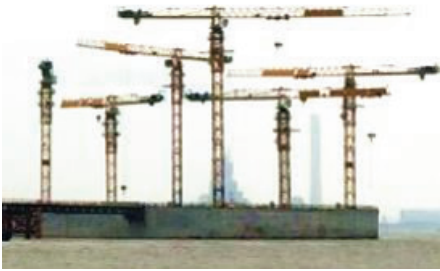
(a) 北塔吊沉井现场
